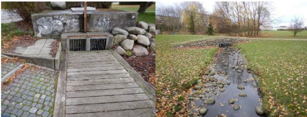
Figur 5-13. Afløb fra Rebæk sø (venstre), og tilløb med iltningskanal på nordsiden af søen (højre).
