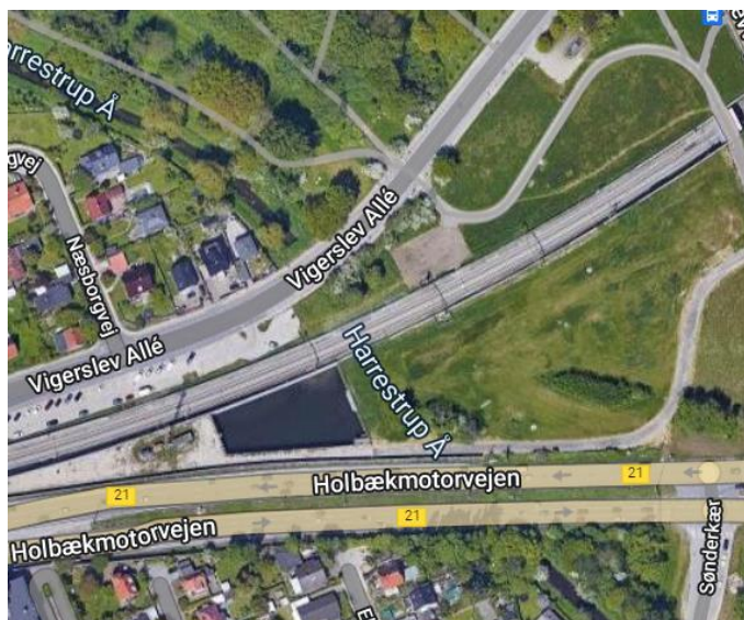
Figur 2-9. Det anlagte betonbassin ved Ringstedbanen (Billede fra Google Maps, august 2022).
