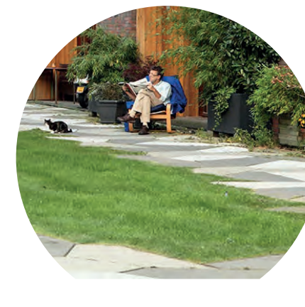
Kant fx niveaufri overgang, ingen kant.
