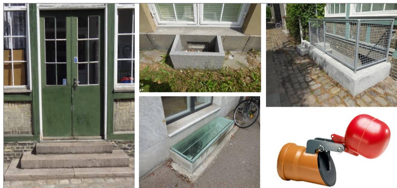
Figur 40 Forskellige metoder til sikring af bygninger mod vand fra skybrud. Hævet indgang og opkanter omkring ventilation, kældernedgange og lyskasser sikrer mod vand fra terræn, mens et højvandslukke til kloak sikrer mod tilbageløb fra kloakken.
