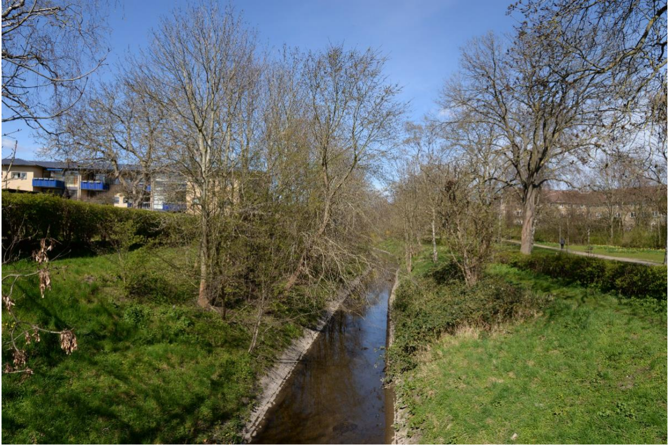
Figur 1-2 Harrestrup Å med flisebelægningen der skal fjernes som en del af projektet.
