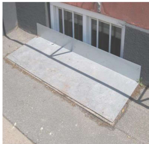
Figur 19: Bygninger kan beskyttes mod vand fra terræn med fx opkanter ved kældernedgange og -vinduer og ved ventilationsåbninger. Højvandslukker eller pumper kan sikre, at vandet ikke løber baglæns gennem kloakken og oversvømmer huset.
