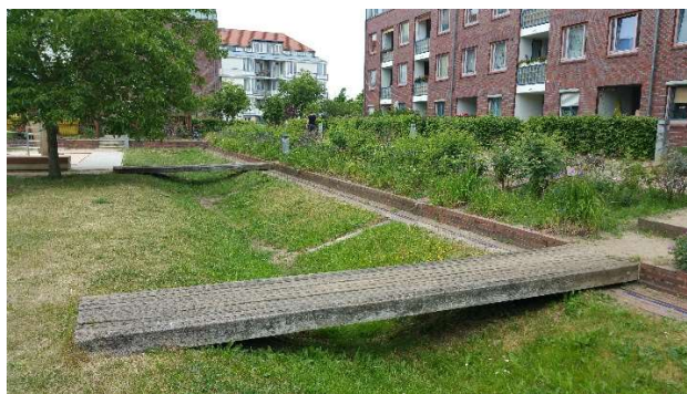
Figur 9: Adgang til boliger over grøft
