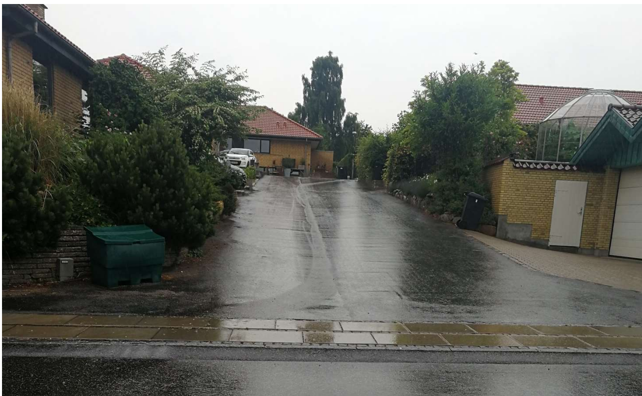
Figur 12: Afledning af vand i midten af vejprofilet, Pigekvarteret, Middelfart
