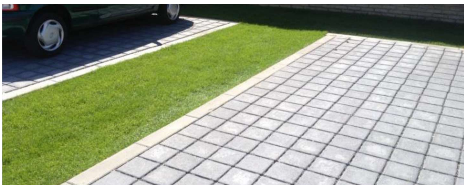
Figur 21: Hvis terrasser og indkørsler lægges med permeable belægninger og med stabilgrus med drænende effekt, bidrager de ikke til oversvømmelser under skybrud.
