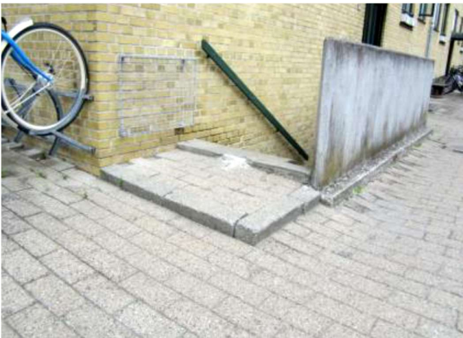
Figur 19: Bygninger kan beskyttes mod vand fra terræn med fx opkanter ved kældernedgange og -vinduer og ved ventilationsåbninger. Højvandslukker eller pumper kan sikre, at vandet ikke løber baglæns gennem kloakken og oversvømmer huset.
