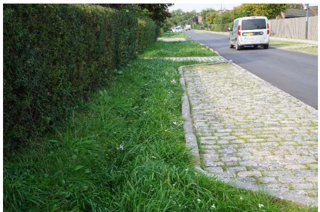
Figur 7: Regnbede og grøft på Lørenskogvej, Rødovre
