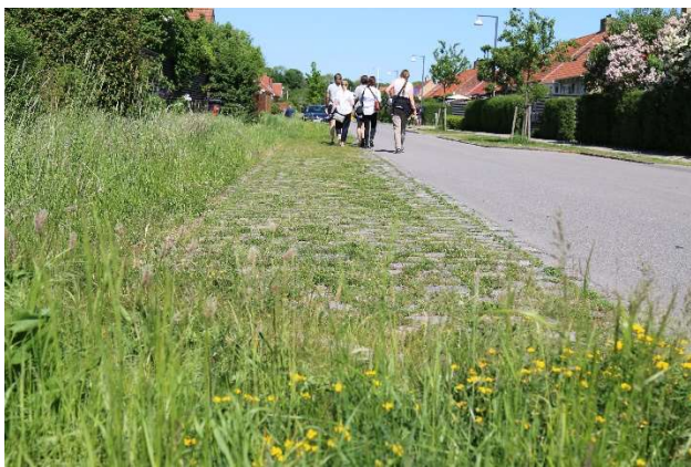
Figur 6: Regnbede og grøft på Lørenskogvej, Rødovre
