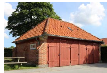
Østre Kvartergade 4, Sprøjtehuset
