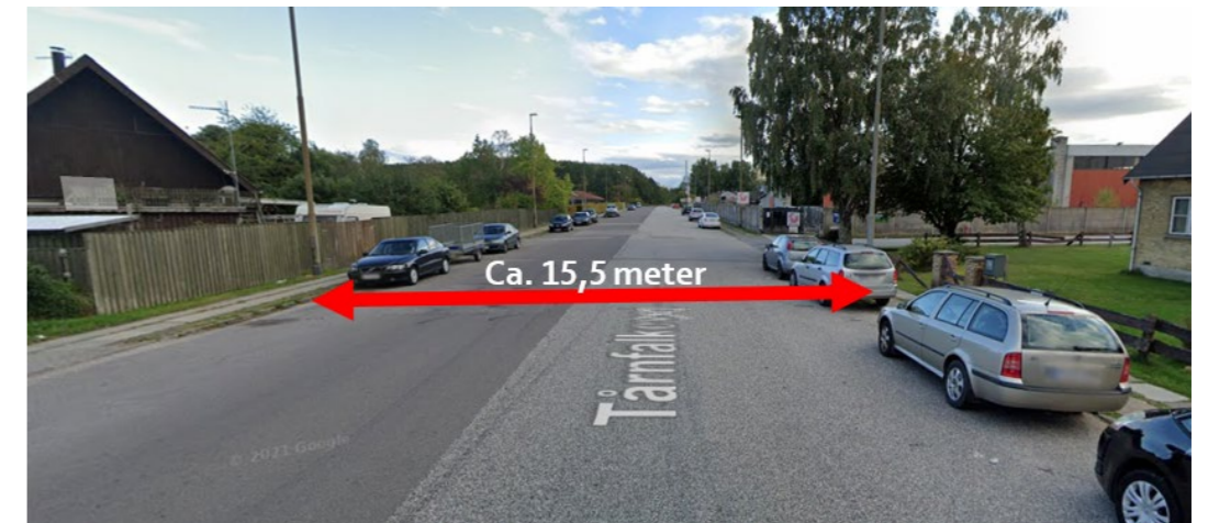
Figur 2. Tårnfalkevej set mod syd. Vejen er meget bred, og langt bredere end den nuværende trafikale funktion tilsiger.
